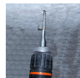
FIX-SUSPENT M6 - mise en oeuvre
