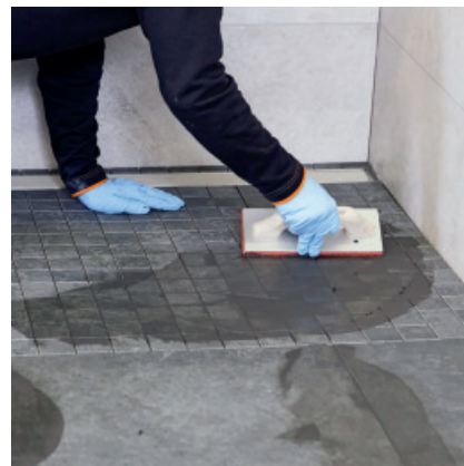
Jointoiment très facile sans voile résiduel avec PCI Durapox Premium (Multicolor).
