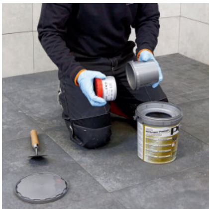
Ouvrir PCI Durapox Premium (Multicolor) et sortir le durcisseur.
