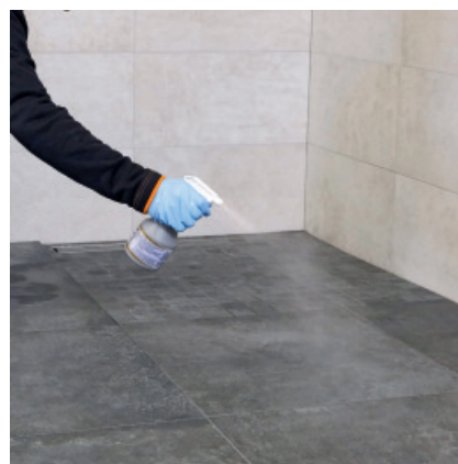
Avant le lavage final, PCI Durapox Finish est pulvérisé sur la surface après 60 minutes environ.
