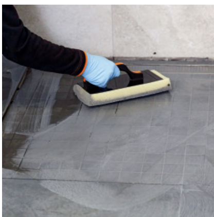
La surface jointoyée peut-être émulsionnée environ 10 à 45 minutes après l'application.
