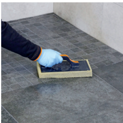
Enlever le voile de matériau restant et nettoyer la surface à l'aide d'une simple éponge (jusqu'à 60 minutes après l'émulsion).
